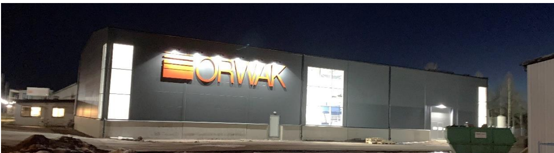
Den nya fabriksbyggnaden i kvällsbelysning med Orwaks varumärke i blickfånget.
